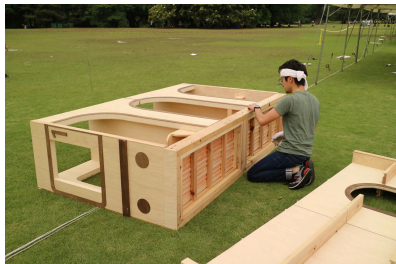
連結： 壁および床の中央部下地を連結 します。
