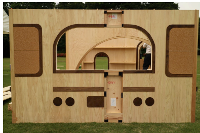
組み立て： 壁面の連結時は、 ベルクロ にて取り付く仕上パネルを脱着します。ボルトはM6。
