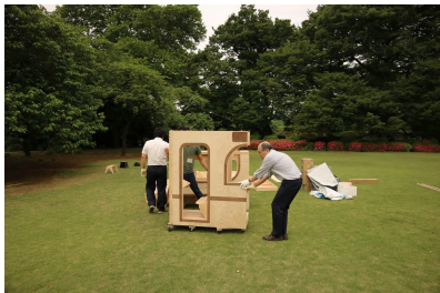
搬入： 各ユニットは半分に分割できるので 一人で台車 で動かせます。
