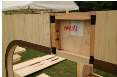
各ユニットは屋根パネルを設置後、2本の横架材を渡すことで全体をつなぎます。
